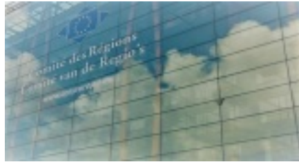
Die Fassade des Ausschusses der Regionen in Brüssel. © European Communities, 2008/ Source: EC - Audiovisual Service/ Photo: Thomas Haley.
